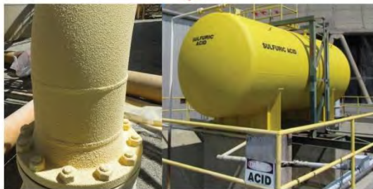
قابلیت عایق کاری سطوح بسیار پیچیده و غیر قابل عایق کاری با عایقهای رایج
