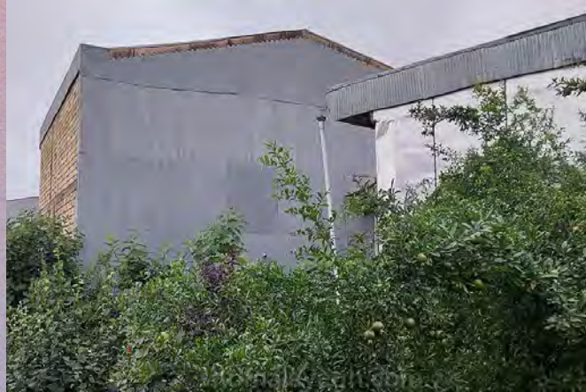
دیوار فلزی کار گذاشته شده بر روی دیوار با فاصله چند سانتیمتری برای جلوگیری از برخورد مستقیم باران با دیوار
