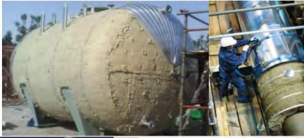
*** وزن بسیار کم رنگ عایق حرارتی بر روی سازه ها
