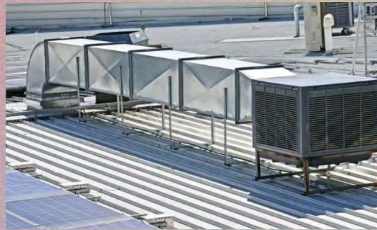
نمونه ای از کولر آبی با کانال فلزی زیر تابش مستقیم آفتاب و بدون عایق
