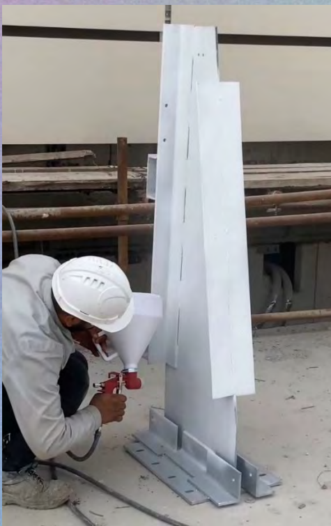
حذف پلهای حرارتی سازه فلزی در عسلویه با نانوعایق هواژل
