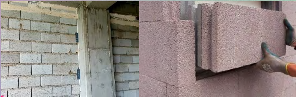
مصالح ممکن است درزهایی مستقیم داشته باشند یا ملات بین مصالح لزوماً عایق حرارت نیست
